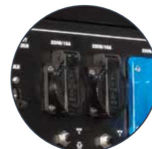
Индивидуальные предохранители на розетках 16 А
